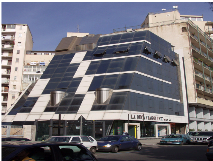
Fig. 7 - Carmelo Borzi, Edificio per uffici Prisma Palace, Catania, courtesy Salvatore Borzi
