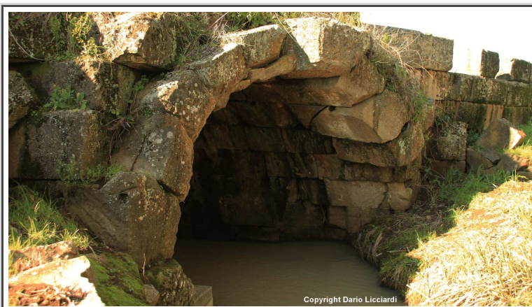
Fig. 6 - Ghiera dell'arco del ponte Loreto con blocchi di peperino in opera quadrata, II-I sec. a.C., Lanuvio (Rm).
