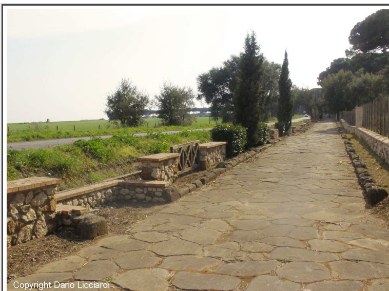
Fig. 19 - Antico basolato stradale in leucite (particolare), località la "Campana", Nettuno (Rm).
