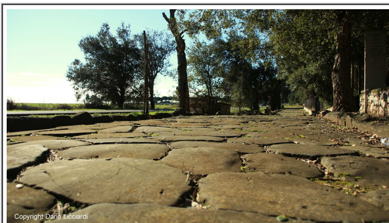
Fig. 18 - Antico basolato stradale in leucite e cigli dei marciapiedi (particolare), località la "Campana", Nettuno (Rm).
